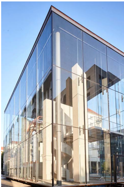
Bild 3: Eine Herausforderung in der Fassadenbemessung bestand darin, dass Dach und Fassade in Bezug auf Lasten entkoppelt werden mussten. (Quelle: ISOLAR® Glas)
