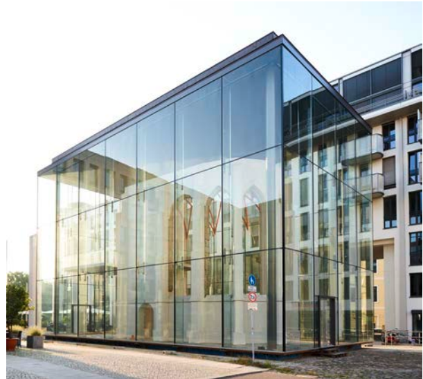
Bild 2: Die Hülle der Gedenkstätte wurde als tragende Ganzglaskonstruktion ausgeführt mit einer Fassadenhöhe von 13,5 Metern. (Quelle: ISOLAR® Glas)
