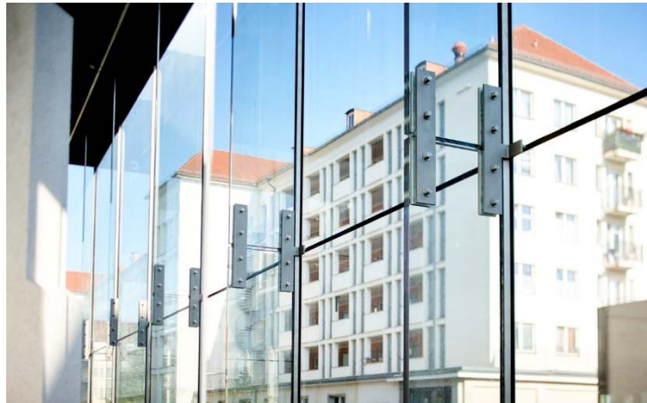
Bild 4: Die gläserne Vitrine besteht insgesamt aus 18 Glasschwertern, montiert im Abstand von 3 m, sowie vier Edelstahlpfosten in den Ecken. (Quelle: ISOLAR® Glas)
