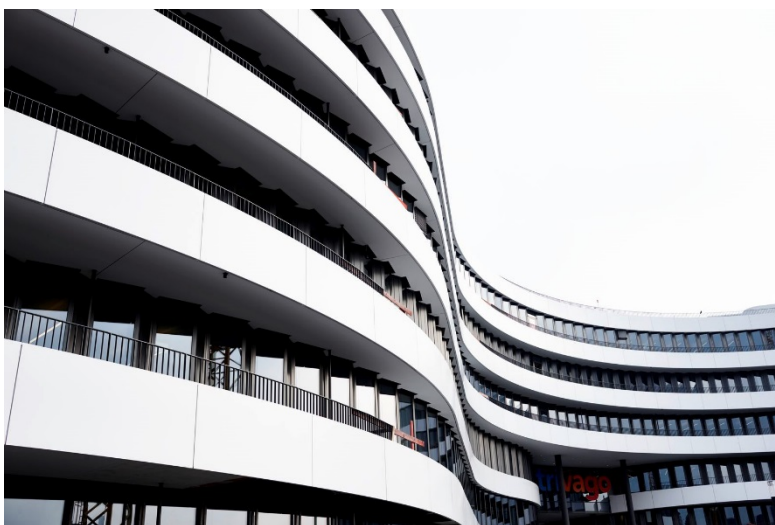
Bild 3: Die horizontal gegliederten Fassade definiert sich durch plastisch hervortretende Brüstungsbänder. (Quelle: ISOLAR® Glas)
