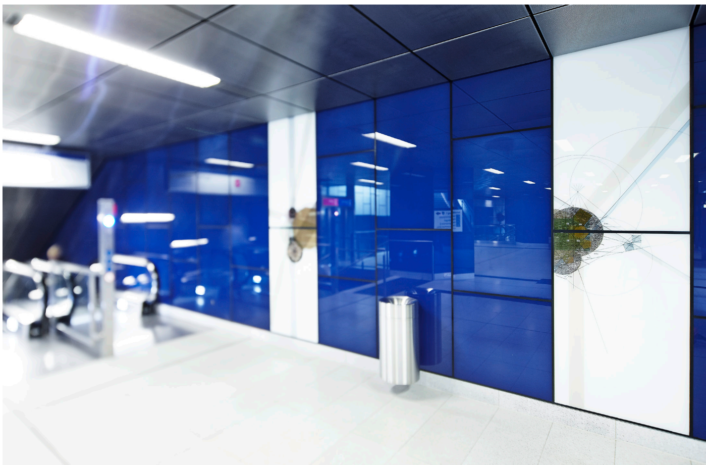
Szkło MONOPACT® zadrukowane w technologii sitodruku zastosowane w bezpiecznym szkłe laminowanym - linia metra Wehrhahnlinie w Düsseldorfie.
