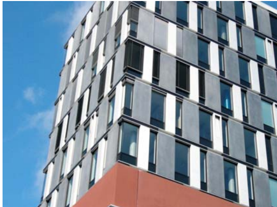
Bild 4: VACUREX® Hochleistungspaneel am Science Park, Saarbrücken
