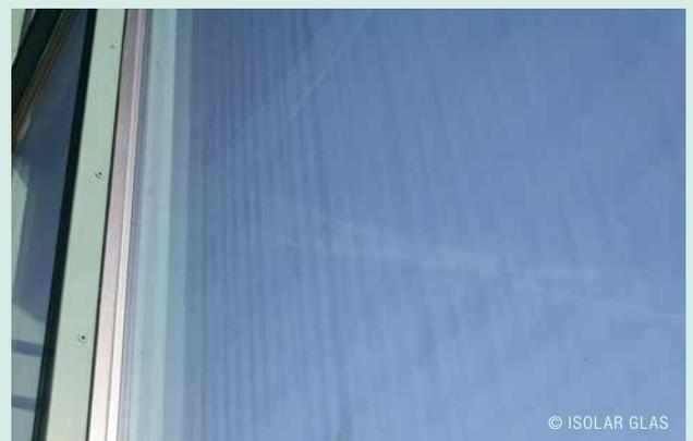
Anisotropieerscheinungen an beschichtetem ESG (Isolierglas) in der Blickrichtung von innen nach außen
