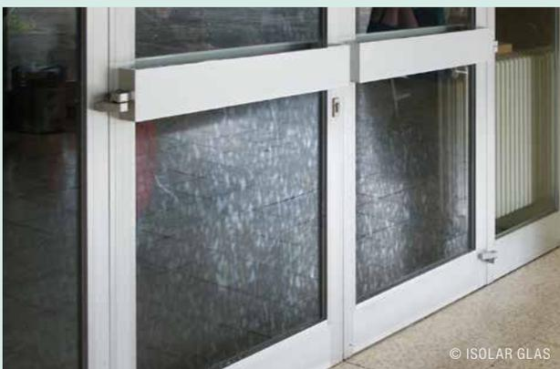
Anisotropieerscheinungen an unbeschichtetem ESG (Einfachglas) im Innenbereich
